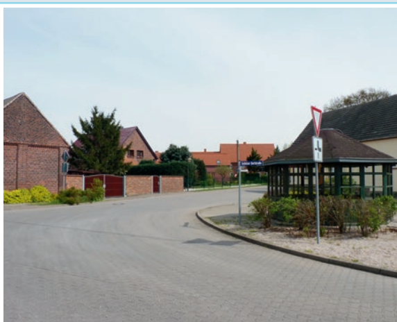
Innerörtlicher Straßen- und Wegebau zur Erschließung der Wohnbebauung im Ortsteil Selbitz. (Foto: C. Rosenkranz)
