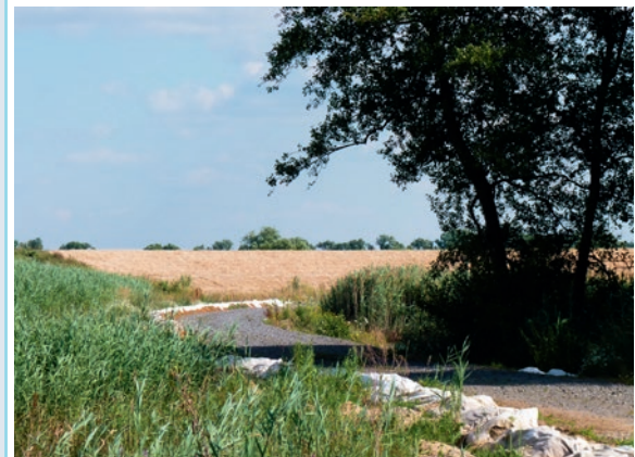
Deichzufahrt bei 10 Ruthen, Hochwasser 2013 (Foto: C. Rosenkranz)
