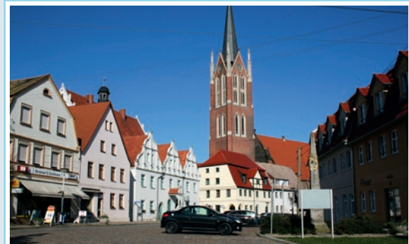
Kemberger Markt vor der Sanierung im Sommer 2013. (Foto: W. Bock)
