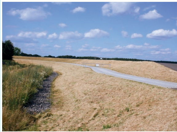
Fertiggestellter Deichabschnitt bei Dabrun. (Foto: W. Bock)
